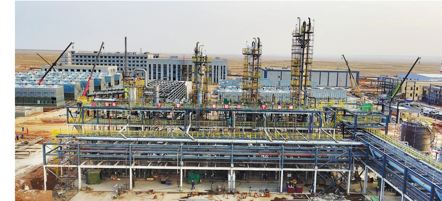
项目建设稳步推进 近期,乌海高新技术开发区低碳产业园内,9个市级重点项目稳步推进建设进度。图为10月30日,内蒙古华恒能源科技有限公司PT-MEG、PBAT新型材料产业链一体化项目建设现场有序施工。(路静 摄)
