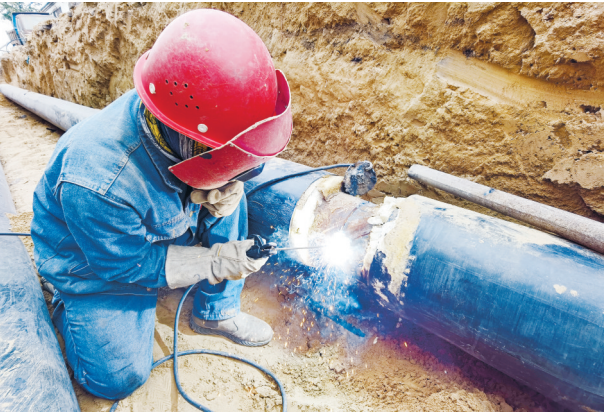
供暖管道焊接。
