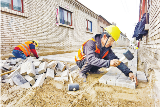
巷道硬化恢复。
