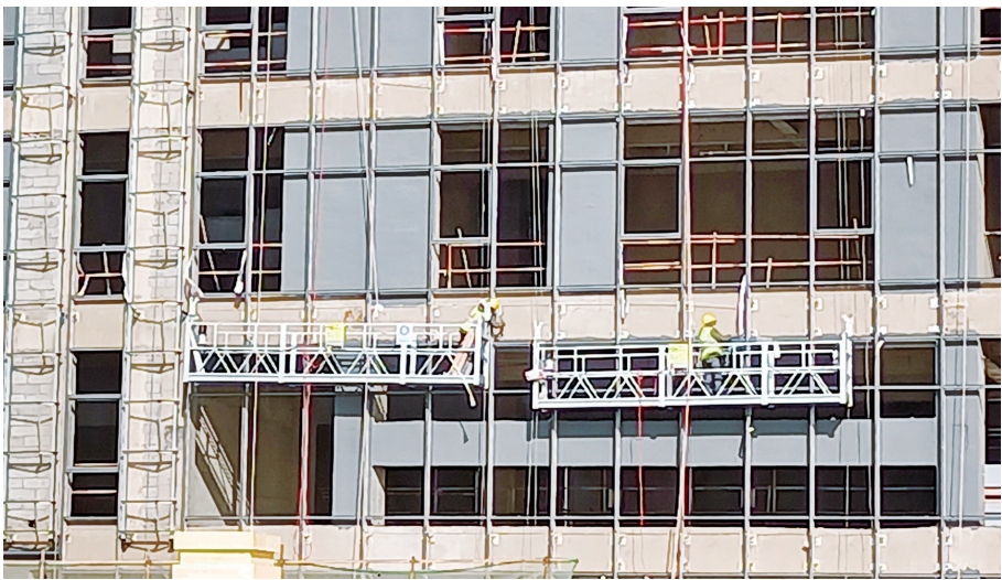
内蒙古兴发科技有限公司工人进行楼体幕墙施工。
