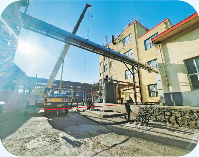
部分附属设施拆除施工现场。
