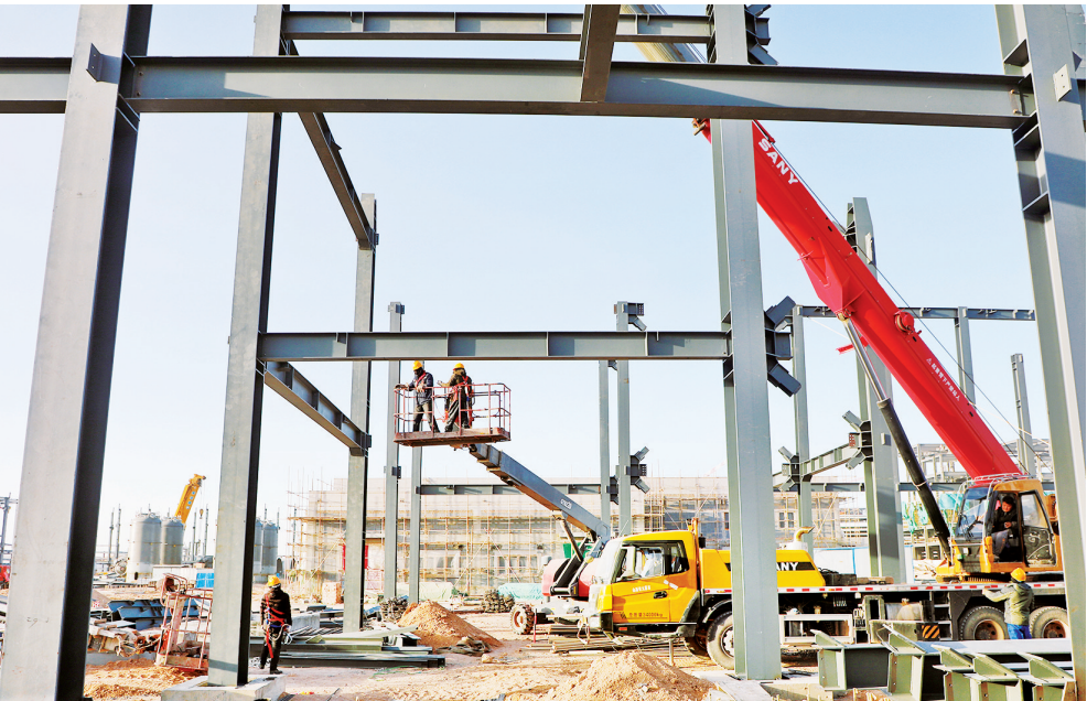
乌海高新技术产业开发区低碳产业园内蒙古三维新材料有限公司BDO一体化项目建设现场。项目规划建设90万吨/年BDO及可降解塑料一体化项目。（高端鹏 摄）
