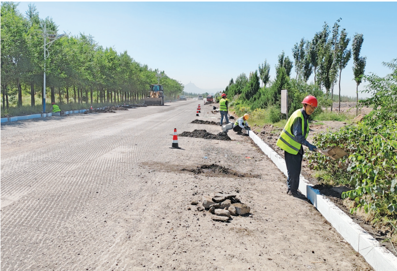
工人在新丰路开展养护工程。
