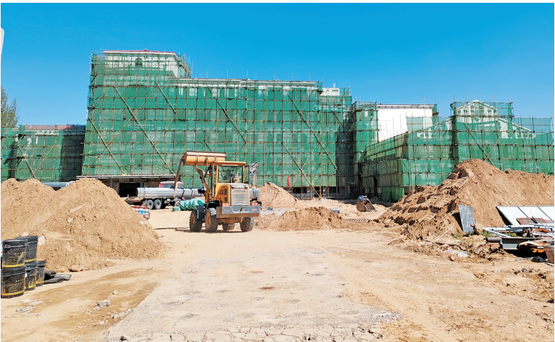
改建项目施工现场。
