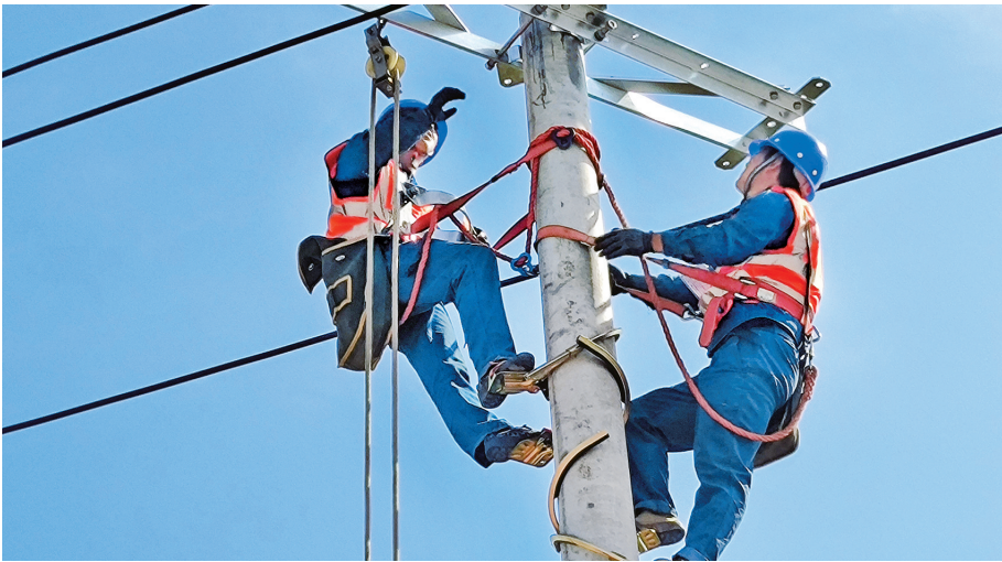
电力检修人员进行施工作业。
