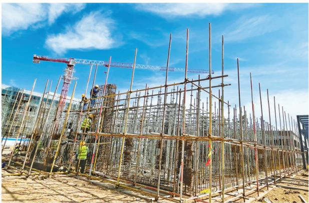
工人搭建钢筋骨架、脚手架。
