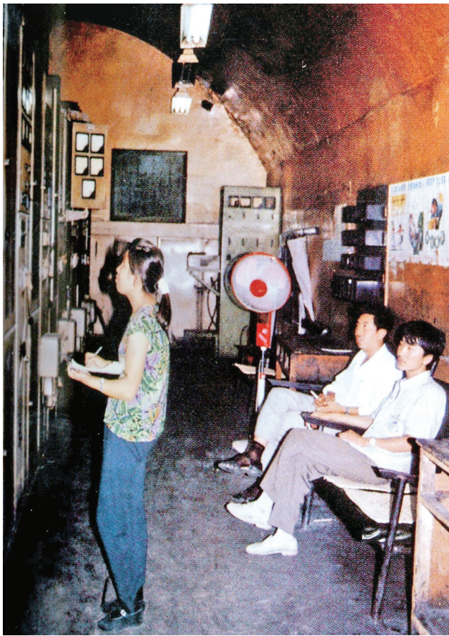
内蒙古跃进火力发电厂主控室。(资料图)
