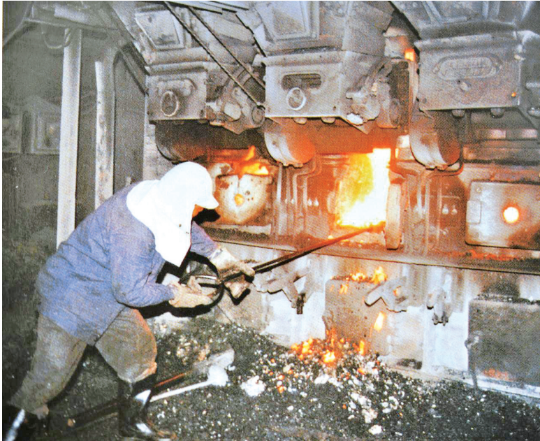
锅炉车间工人在炉膛前忙碌。(资料图)
