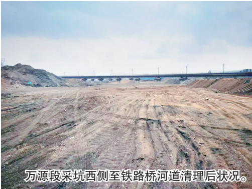
万源段采坑西侧至铁路桥河道清理前状况。
