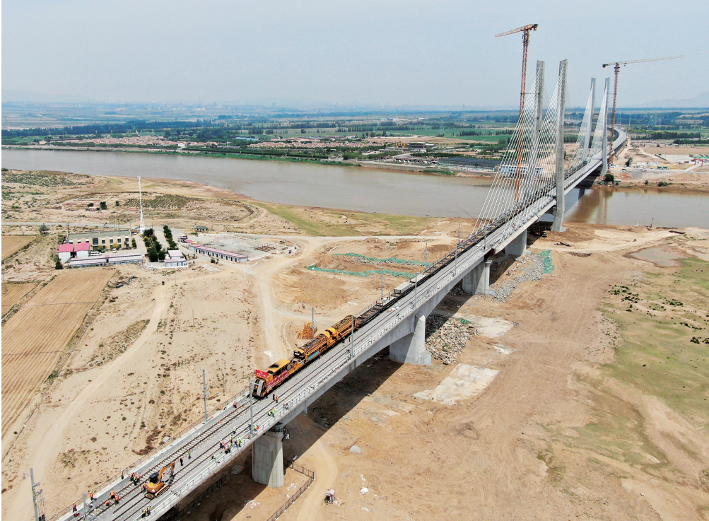
包银高铁乌海黄河特大桥铺轨现场（无人机照片）。（黄建飞 摄）
