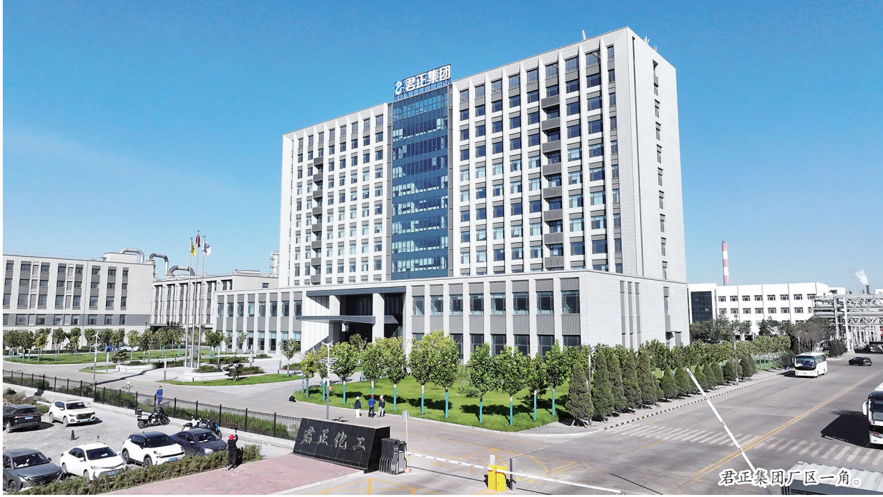
君正集团厂区一角。
