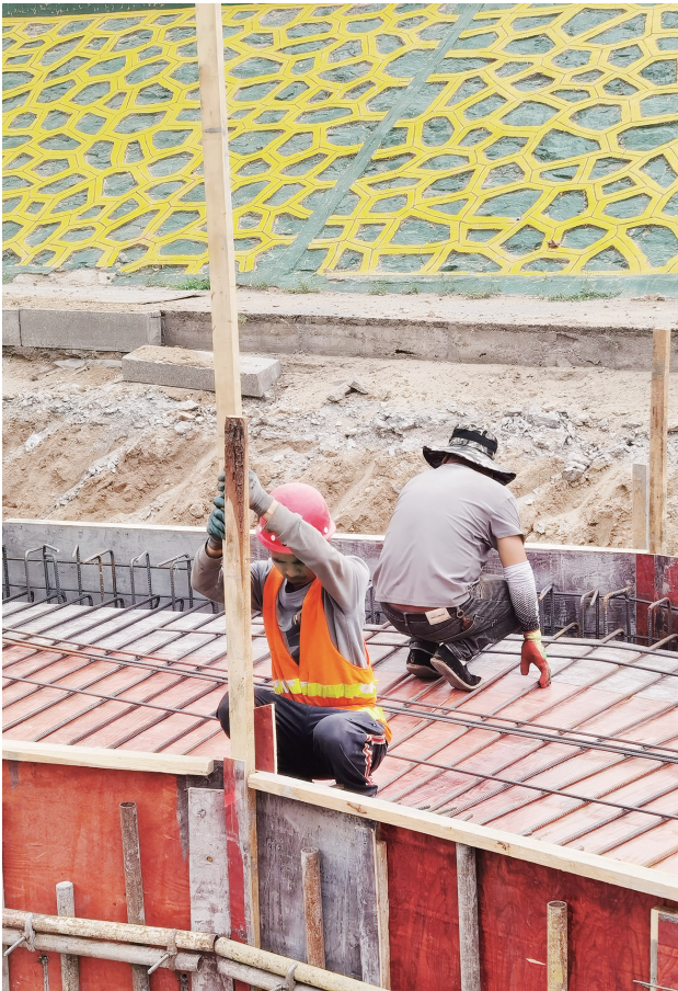
改造现场,工人加班加点。
