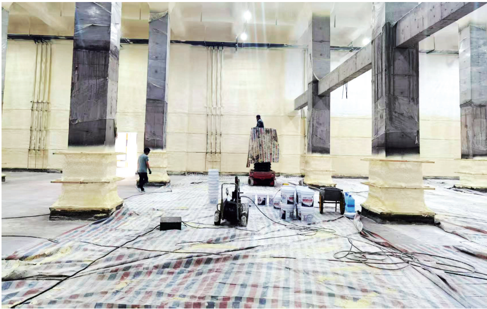
7月25日,工人在中蒙俄特色贸易区智慧仓储冷库施工。
