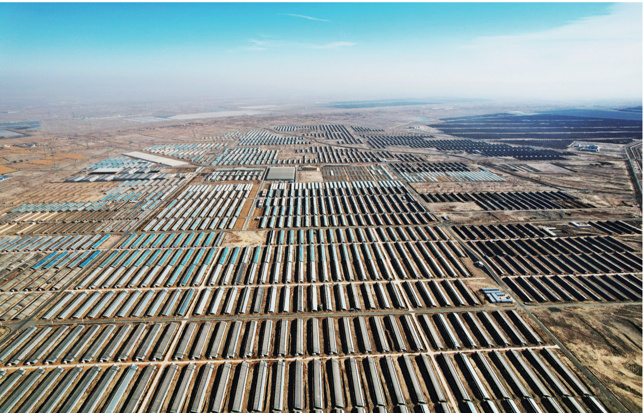
这是2025年11月15日在甘肃省酒泉市肃州区拍摄的戈壁设施农业产业园(无人机照片)。
