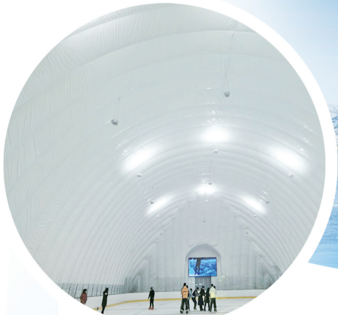
我市首家气膜滑冰场建成并投入使用。
