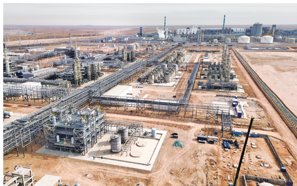
图为建设中的乌海市广锦新材料有限公司BDO—PBAT一体化项目(无人机照片)。(赵政宇 摄)
