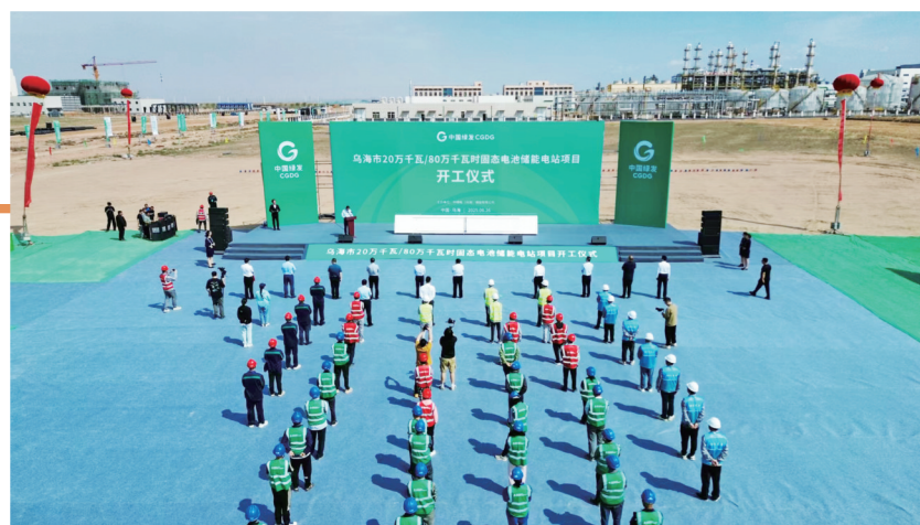
中国绿发投资集团有限公司储能电站项目拿地即开工。(赵政宇 摄)
